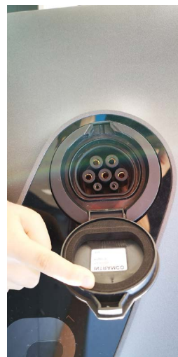
Figura nr. 4 - Stație de încărcare vehicule electrice echipată o priza de încărcare tip 2. (Stația de încărcare este accesibilă publicului)
