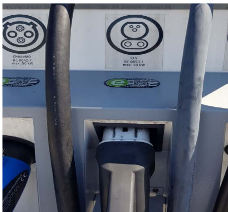
Figura nr. 7 – Punct/ Stație de încărcare VE - echipat/ă cu conector de tip CHAdeMO, conector de tip CCS 2 și conector de tip 2
