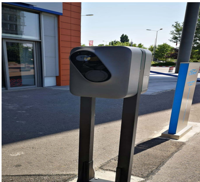
Figura nr. 4 - Stație de încărcare vehicule electrice echipată o priza de încărcare tip 2. (Stația de încărcare este accesibilă publicului)
