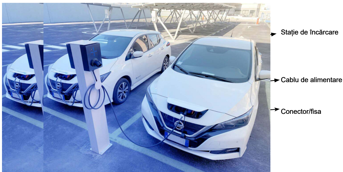
Figura nr. 3. - Stație de încărcare vehicule electrice – componente principale
