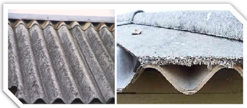
Fig.9. Plăci ondulate de acoperiș din azbociment 23
