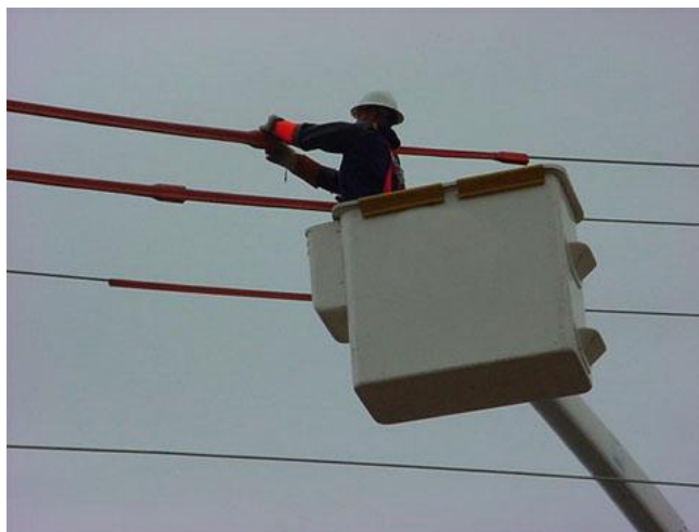
Figura 5.9 – Asigurarea zonei lucru prin aplicarea de protectoare electroizolante pe conductoarele active
