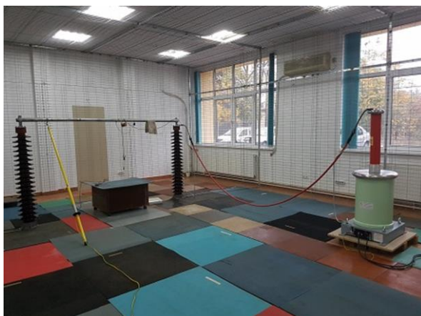
Fig.16 Standul de încercări cu tensiune mărită
